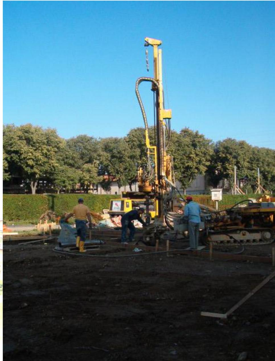
Per il corpo in ampliamento si è proceduto alla realizzazione di fondazione su pali essendo il terreno di scarsa portanza.
